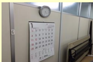
打合せ室の内張りに使用 総厚み30mm 断熱材27mm+アルリーダー木目調3mm
